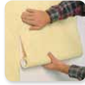
... duvar kağıdını rulodan duvara...
